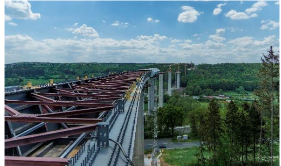
zukünftige Aftetalbrücke in Bad Wünnenberg
