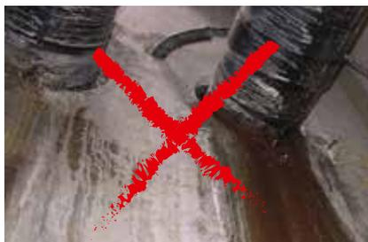
Fehlende Kenntnisse im Bereich Durchdringungen führen zu „Baustellenlösungen“, die nicht dem Stand der Technik entsprechen. Diese Ausführungen halten nicht die geltenden Regelwerke ein und gewährleisten keine dauerhaft sichere Abdichtung.
