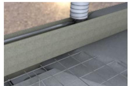
1. Die MBA® Attika Filigran Schalung wird mit dem C-Abstandhalter auf dem Mauerwerk aufgestellt und ausgerichtet. Bei Vollsteinen kann die Schalung zusätzlich genagelt / angeschossen werden.
