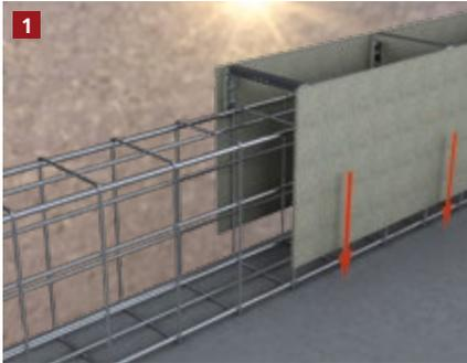
Die MBA® Attika Schalung wird mit der Schalungsöffnung nach unten auf dem Mauerwerk aufgestellt und ausgerichtet.
