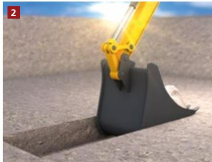
Der Fundamentgraben für die Schalung wird ausgehoben.
