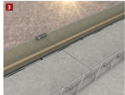
Die Schalung muss gegen Verformung abgesichert werden. Hierzu empfehlen wir bei Schalungen aus Holzbeton unseren HB Top-Verbinder.
