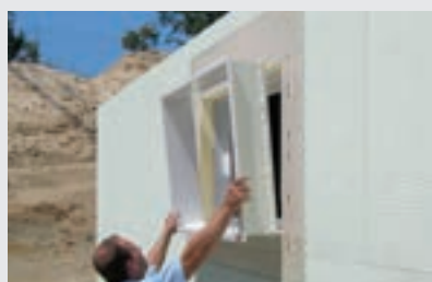
Einfache Montage des Perimeter-Abdeckrahmens
