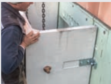
Einhängen des Lichtschachtes an die Dübel
