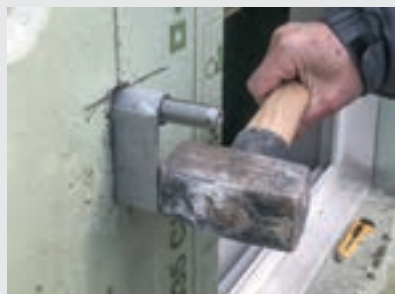
Einschlagen des Befestigungselements
