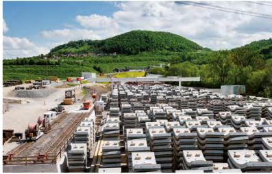
Bossler Tunnel Stuttgart / Ulm, Deutschland
