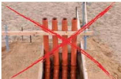
Im Bereich der Haus- und Netzanschlüsse werden häufig Rohre zweckentfremdet eingesetzt (siehe Bilder). Die Anwendung als Durchführungssystem entspricht ohne weitere Maßnahmen nicht dem Stand der Technik und ist für eine dauerhaft sichere Abdichtung gemäß der nachfolgenden Regelwerke nicht geeignet!
