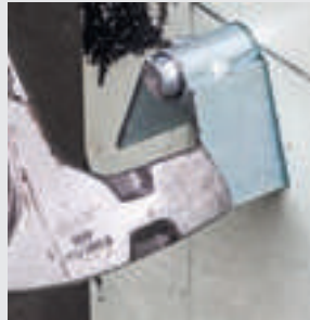
Einschlagen des Befestigungselements
