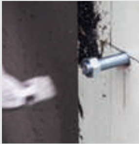
Schwerlastdübel bis zur Hälfte in Betonwand einschlagen
