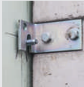
Einhängen des Lichtschachts an die Dübel
