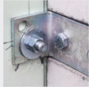
Anschließend alle Muttern wechselseitig vollständig festziehen
