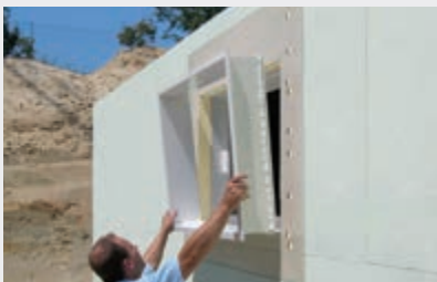
Einfache Montage des Perimeter-Abdeckrahmens
