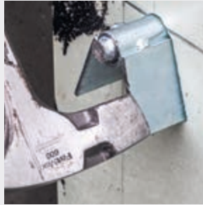
Einschlagen des Befestigungselements
