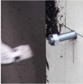
Schwerlastdübel bis zur Hälfte in Betonwand einschlagen
