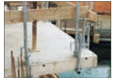
Schutzgeländerzwingen an Betondecke ange- schlagen.
