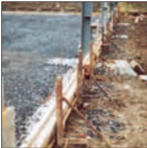
Schalhilfe zur Erstellung von Bodenplatten.
