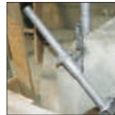
Schutzgeländerzwingen im Treppenbereich angeschlagen.
