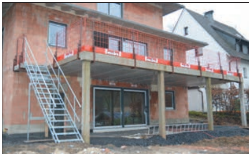
AS- System im Einsatz mit T-Trägerklemmen
