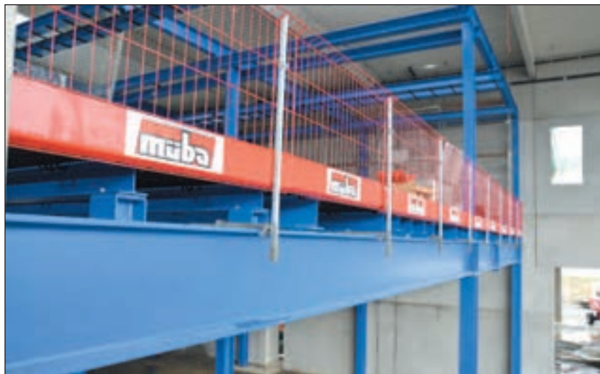
AS- System im Einsatz mit T-Trägerklemmen
