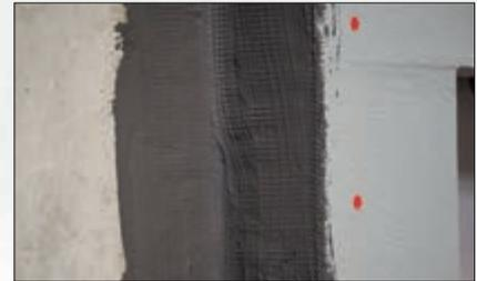
Montagekleber MEABOND auf Perimeter-Abdeckrahmen aufbringen und diesen anschließend gleichmäßig in Öffnung einschieben. MEAFIX PRO umlaufend mit 2-lagiger mineralischer Dickbeschichtung und eingebettetem Glasseidengewebe abdichten.
