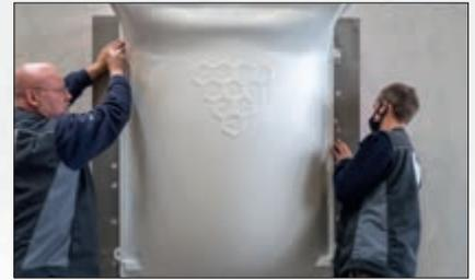
Lichtschachtmontage: Je nach Lichtschacht-Typ Dämmstoffdübel an passender Stelle eindrehen. Lichtschacht mit eingelegtem Gitterrost oben einhängen, anschließend Schrauben oben und unten eindrehen und Lichtschacht damit fixieren. Fertig!
