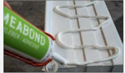
Kleber gleichmäßig auf Dämmstoffrückseite aufbringen. Anschließend an Wand anpressen, dabei nach Fensterzarge ausrichten, nach Möglichkeit Perimeter-Abdeckrahmen zur Positionierung einschieben (ggf. klemmen). Gegen Absenken abstützen.
