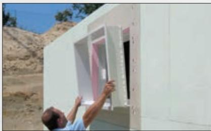
Einfache Montage des Perimeter-Abdeckrahmens
