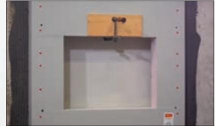
Nach der Grundierung der Betonwand Dickbeschichtung anrühren und auftragen. MEAFIX PRO an Wand kleben und gegen Verrutschen sichern.
