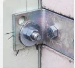
Anschließend alle Muttern wechselseitig vollständig festziehen
