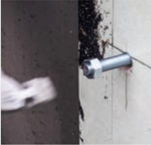
Schwerlastdübel bis zur Hälfte in Betonwand einschlagen
